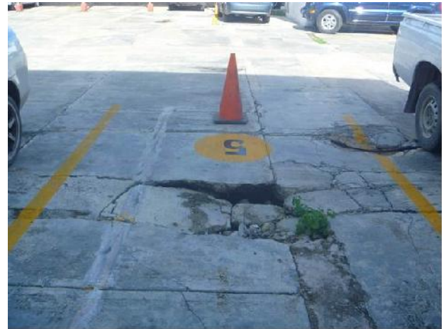
Fotografía 2. Hundimiento en calle zona centro.
